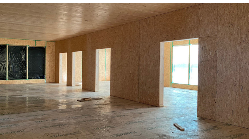
➤ Steht der Rohbau, kann es im Innern weitergehen: Elektro-, Heizungs-, Lüftungs- und Sanitärarbeiten stehen als nächstes an. (Foto: Kreisstadt Unna)
